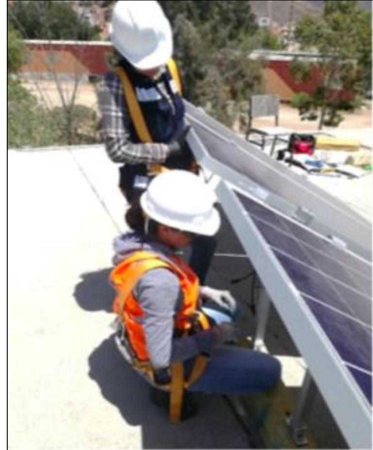
Ilustración 1. Fijación de módulos.
